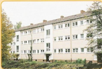
Zustand vor Sanierung
